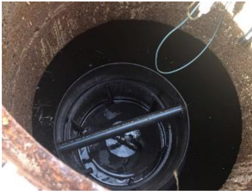
Foto: Controle op drijfvermogen vlotter
