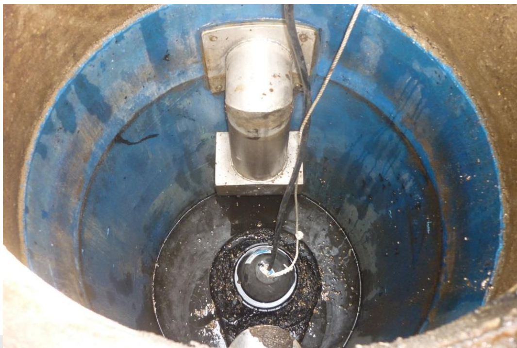
Foto: Afsluiter in afscheiderinstallatie.
