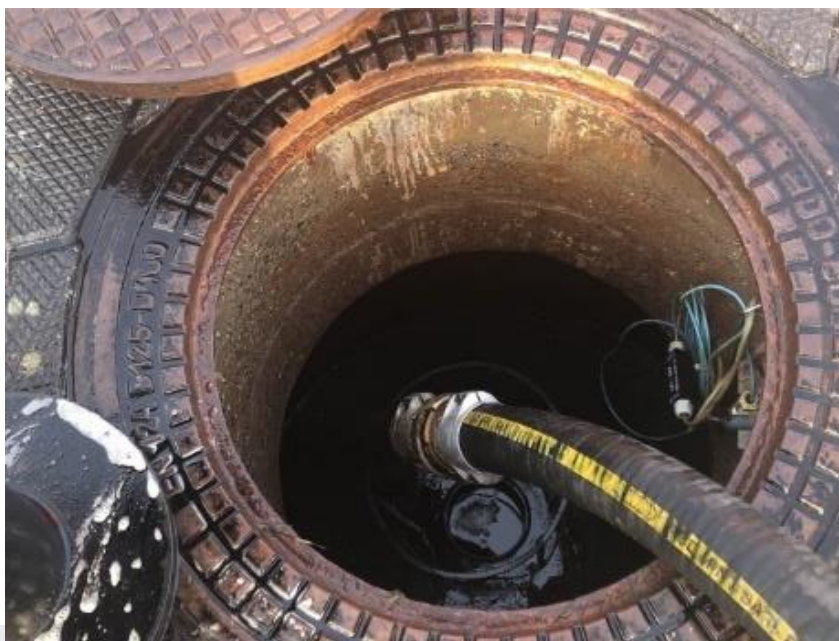
Foto: Reinigen afscheidingsinstallatie
