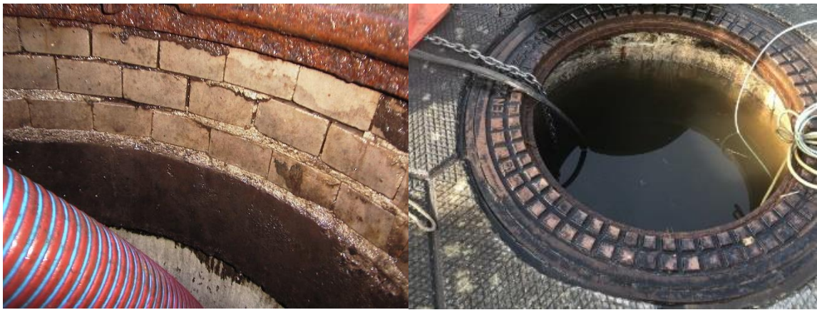
Foto: Metselwerk boven maximale bergingsmogelijkheid
