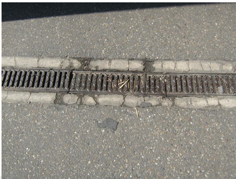
Foto: Aansluiting op lijngoot.
