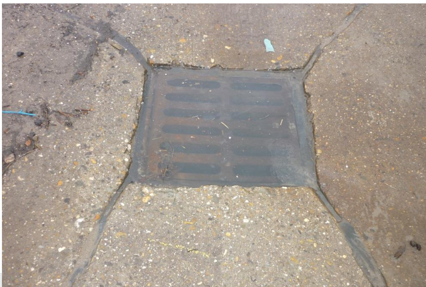
Foto: Ontvangpunt tot bovenzijde gevuld met water.
