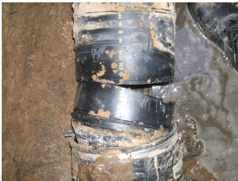
Foto: Lekkage/breuk in leidingwerk.
